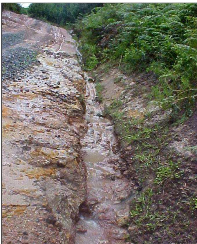
Figura 6 – Afloramento do arenito Botucatu pouco alterado, mostrando sulcos provocados pela erosão.
