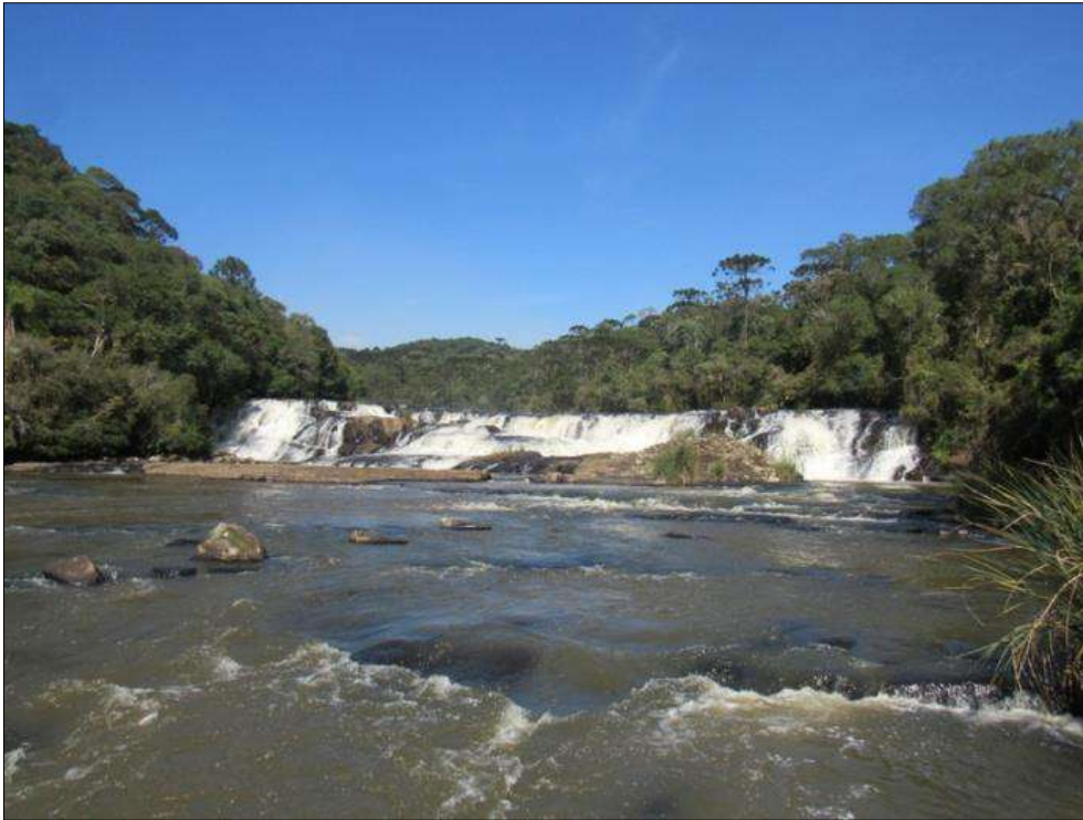
Figura 191 - Ambiente lótico próximo ao local de instalação do Barramento da PCH Tamanduá (UTM 22J 526848X/7069101Y).
