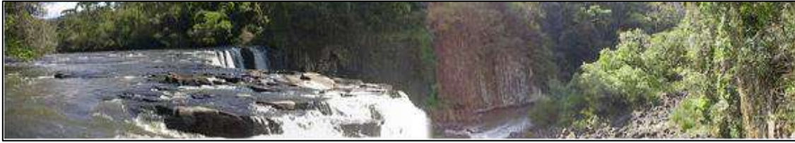
Figura 196 – Queda d'água a jusante do barramento da PCH Tamanduá.
