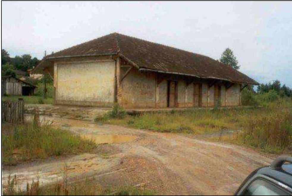
Figura 209 – Prédio do armazém da Estação Ferroviária de Marcílio Dias – Canoinhas.
