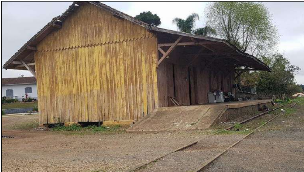
Figura 211 – Estação Ferroviária Valões – Irineópolis.
