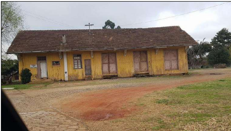
Figura 210 – Estação Ferroviária Valões – Irineópolis.
