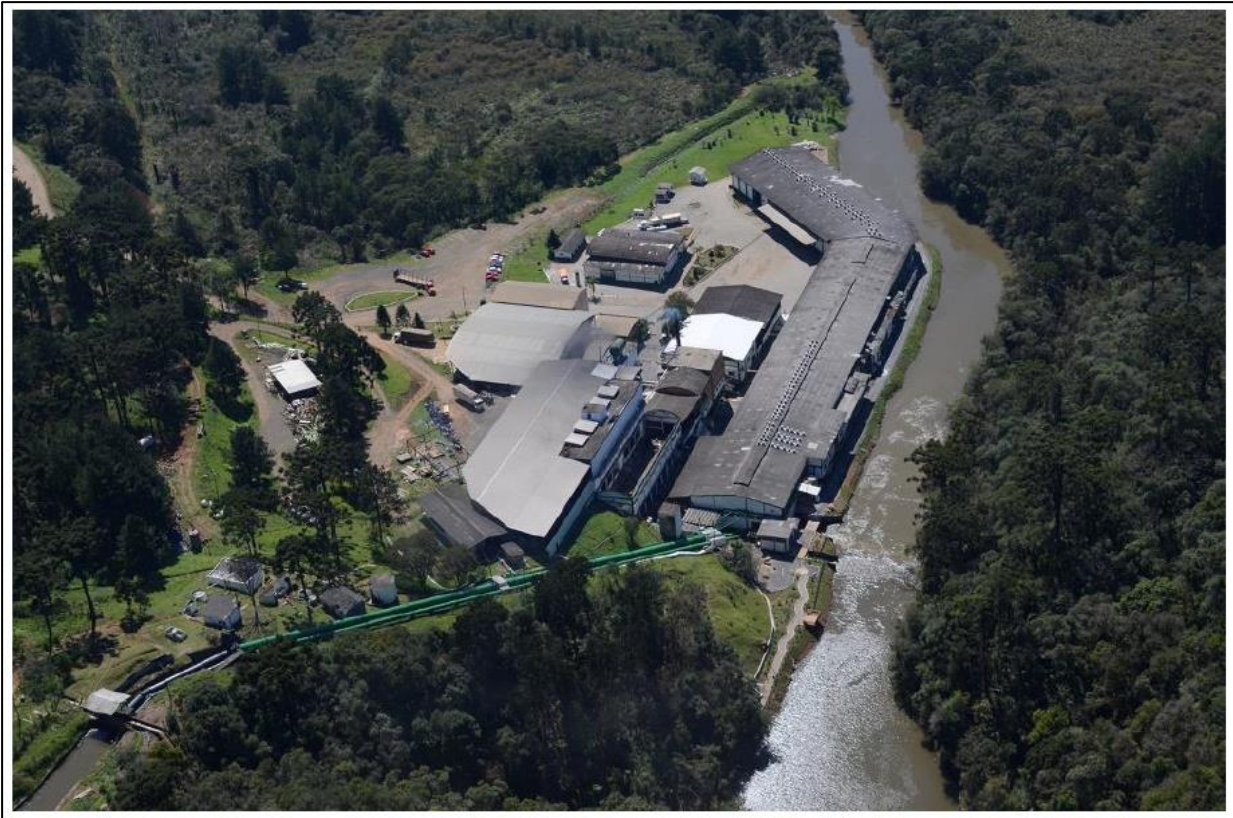
Figura 3 – Condutores forçados e casa de força.
