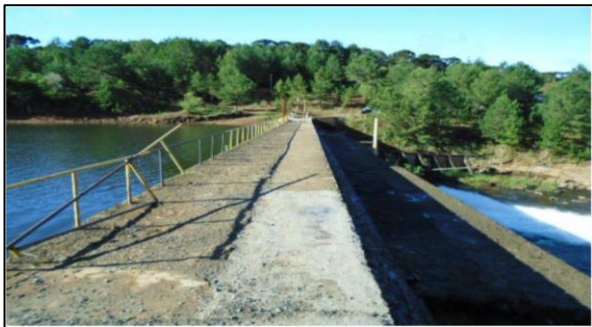
Barramento/vertedor de regularização
